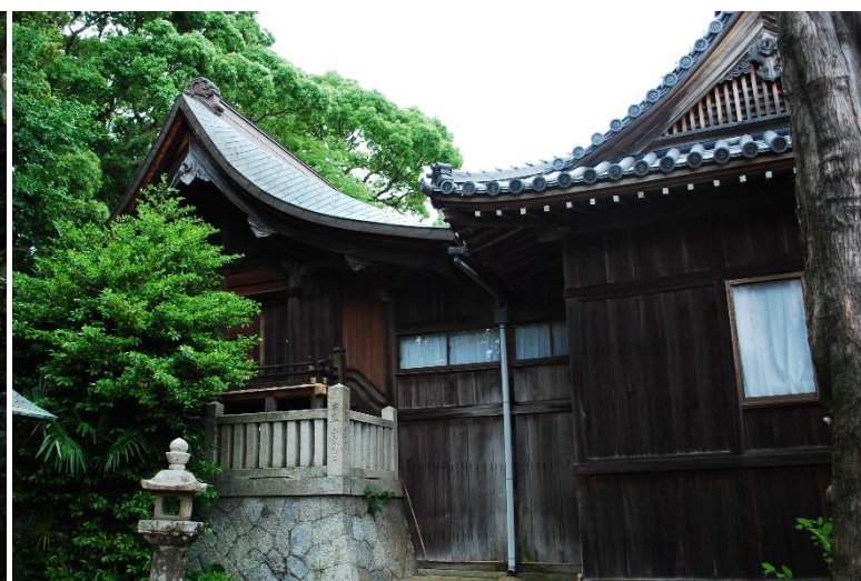
＜鳥飼八幡宮本殿(県重要文化財)／幣殿／前殿＞
